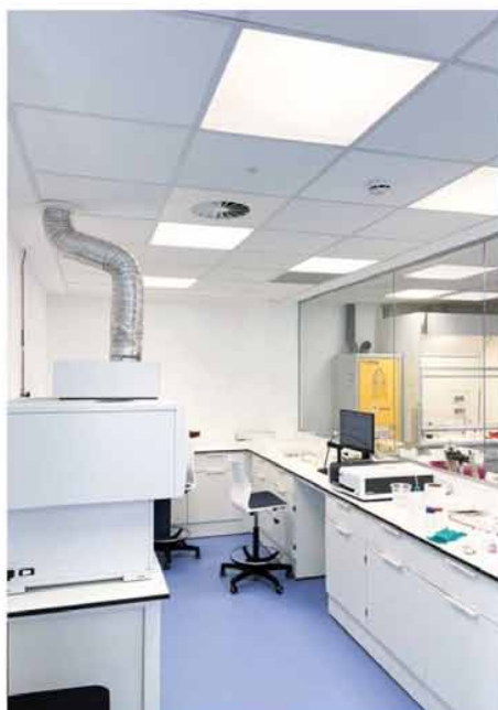
Detalle de las tiras LED en áreas funcionales del Laboratorio de Aqualia.
