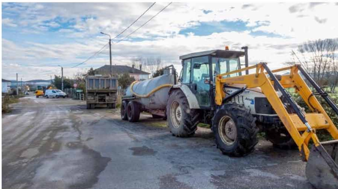
Obras de reparación, este martes, de una nueva avería en la calle Juan Montes
