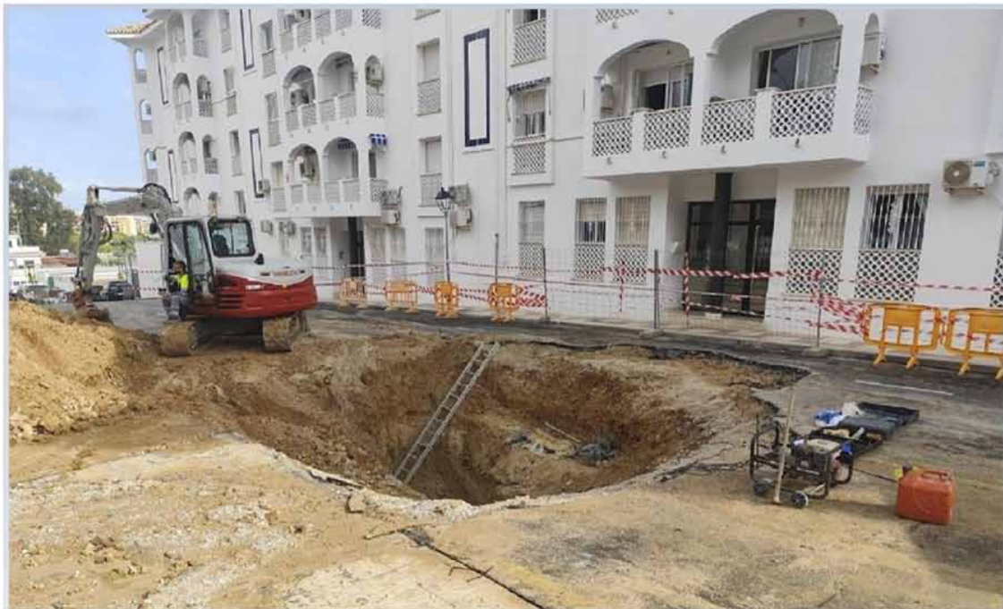
Acosol trabaja ya en la reparación de la nueva rotura de la tubería de agua de la calle Medina Azahara de Arroyo de la Miel.
