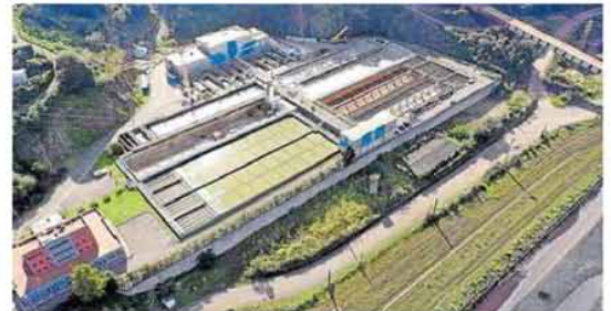
Vista aérea de las instalaciones de la depuradora de La Reguerona, en Aboño, inmersas en obras desde hace tres años para modernizarlas. CHC
