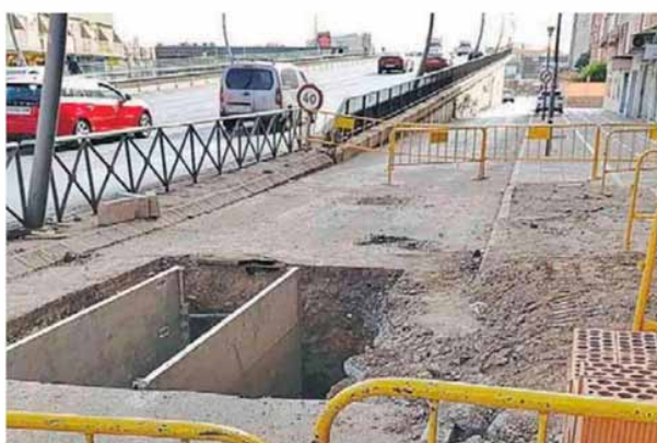
Tramo de las obras del AVE en Almería. E. PÉREZ
