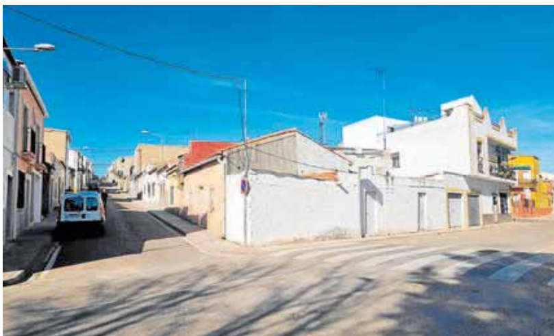
Avenida Casa Herrera que delimita el sector de nueva red de tuberías. J. M. R.
