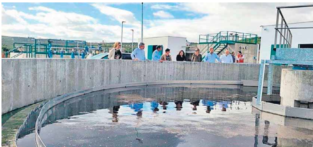
Las autoridades visitan la terminación de la estación depuradora de Lahiguera (Jaén).
