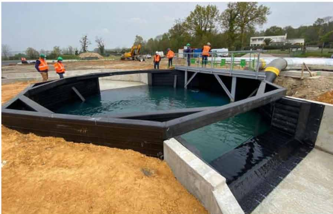
La réalisation dun bassin pour les eaux industrielles à Port-Jérôme-sur-Seine en Seine-Maritime.
